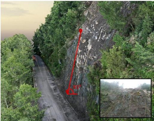
圖 9 目視巡查邊坡視角受限
