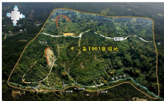
圖1 嘉義縣竹崎鄉白杞村中心崙 T003崩塌地
