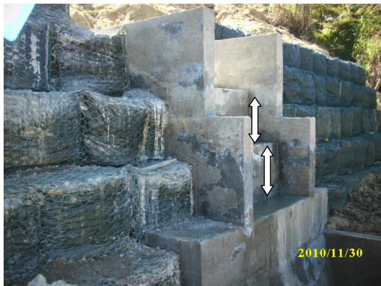
圖 2 大甲溪事業區第 6 號崩塌地整治復舊計畫工程示意圖(林務局，2011)(跌水工共計 2 處，如照片箭號處，設計 1.0m 高，現場 0.8m 高)
