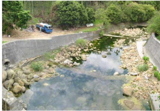
a.平 9，護岸與固床工，向下游
