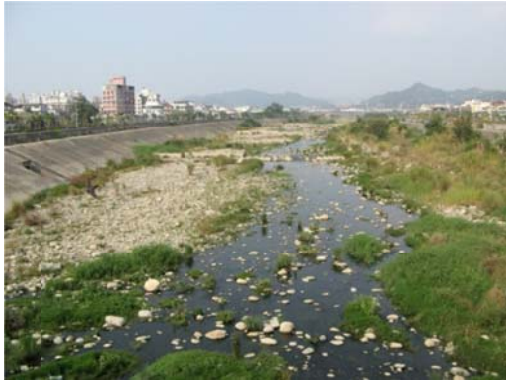
a. 里 4，護岸與固床工，向上游
