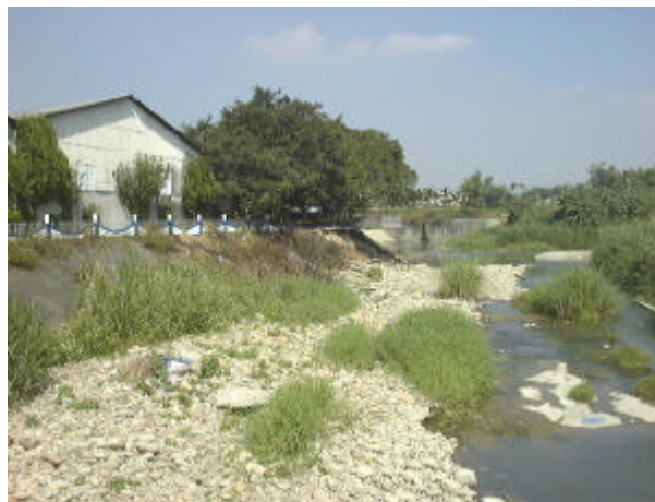
筏子溪烏橋上游混凝土堤防原貌
