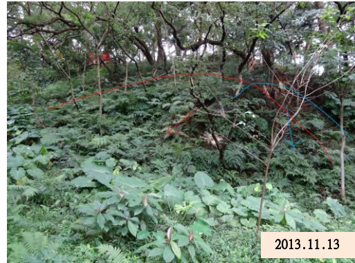
圖 5 案例 A 中發現新增淺層滑動區 Figure 5 Shallow landslide in Case A
