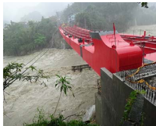
圖 1-1 2012 年 8 月 2 日颱風造成鋼樑下陷 Fig. 1-1 August 2, 2012 steel beams subsidence caused by typhoon
