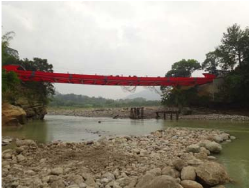
圖 1-2 蘇拉颱風後，只剩少數支撐遺留現場 Fig. 1-2 Aftermath of Typhoon Sura, Only a few support left on site
