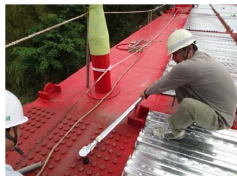
圖 3-21 高張力螺栓扭力值檢測 Fig. 3-21 High tensile bolts torque value testing
