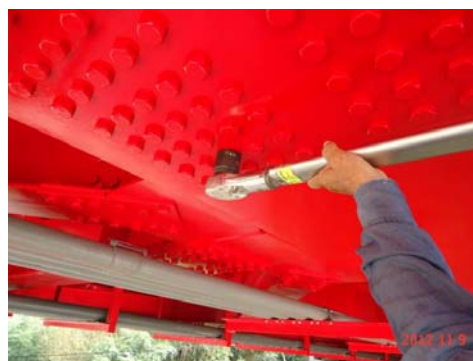
圖 3-9 高張力螺栓扭力值檢測 Fig. 3-9 High tensile bolts torque detection
