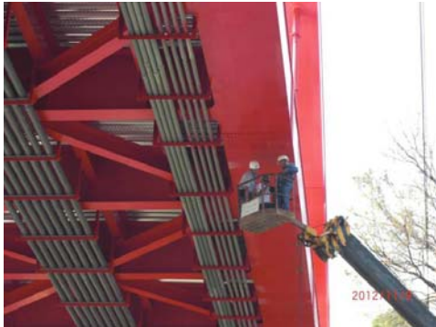
圖 3-22 檢視接合板、油漆面及高張力螺栓 是否異常
