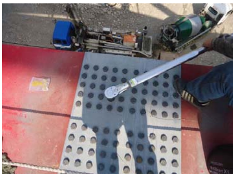
圖 3-18 扭力值重新檢測 Fig. 3-18 Re-torque value testing
