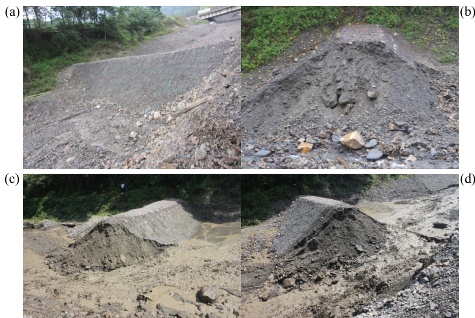
圖 4 (a)破壞前-由下游面往上游面拍攝 (b)破壞後-由左岸向壩軸之方向拍攝 (c)破壞後-由左岸上游面向下游拍攝 (d)破壞後-由左岸下游面向上游拍攝 (由陳樹群提供)
