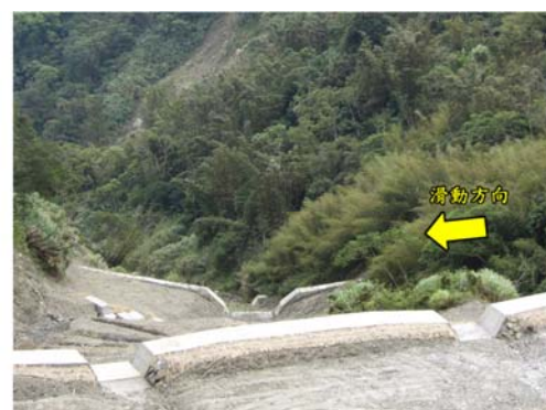
圖 11 崩塌區內新建之防砂壩
