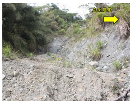
圖 10 瀨頭野溪左岸崩崖之崩積土
