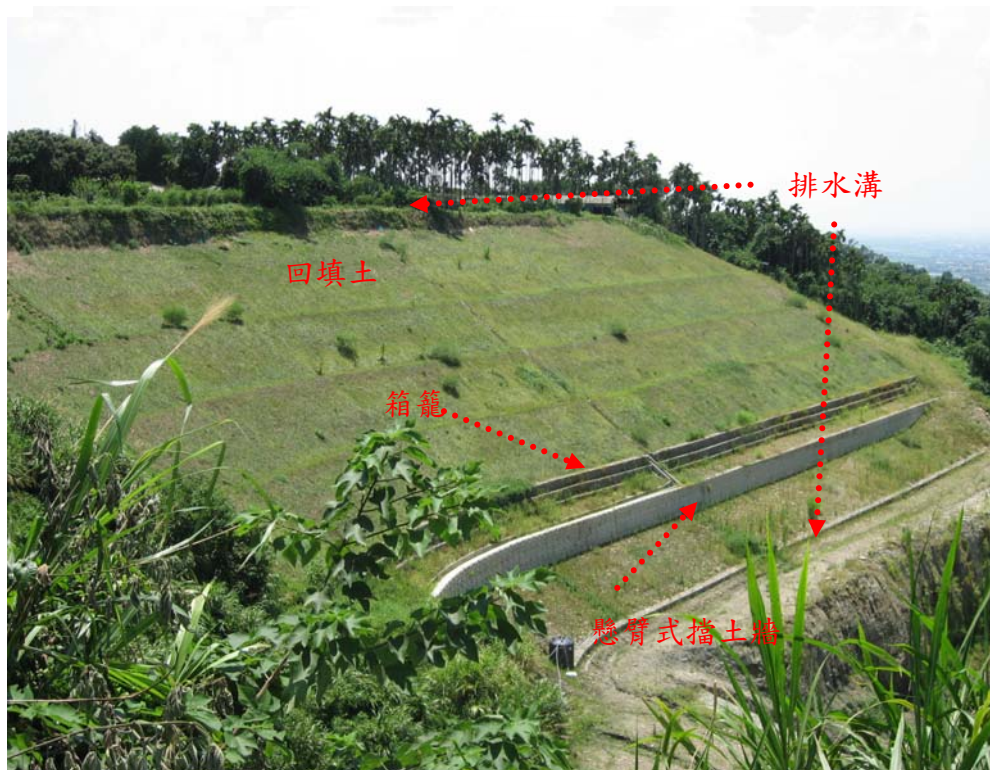
圖 9 林北坑邊坡複合型工程(來源：鋒璟公司，拍攝時間：2007)
