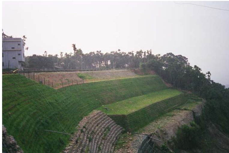
圖 3(a) 加勁擋土牆施工完成照片(來源：鋒環公司，拍攝時間：2003)
