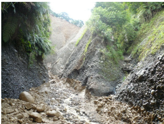
圖9. 土地公坑溪上游崩塌地(1)
