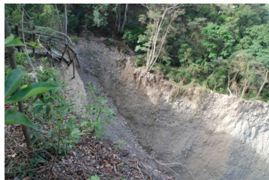
圖17. 土石流沖毀大坑一號步道
