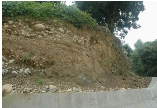
圖14. 順向坡平面型滑動
