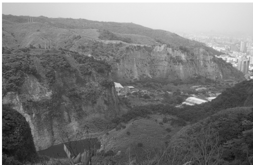
照片 1. 第一坑洞上視照片(後方為第二、第三坑洞)
