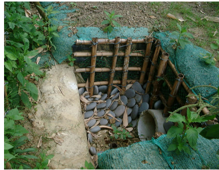
圖 7b. 採用自然資材設計之疊水工 (5) Figure 7b. Waterfall using natural materials (5).
