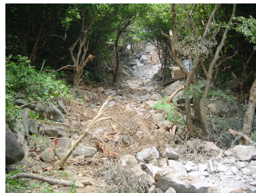
圖 17. 土石流後現地堆滿堅硬塊石 Figure 17. Rocks at the debris flow site.
