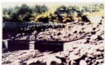
圖 3. 日本燒岳透水柵經土石流後淤滿情形
